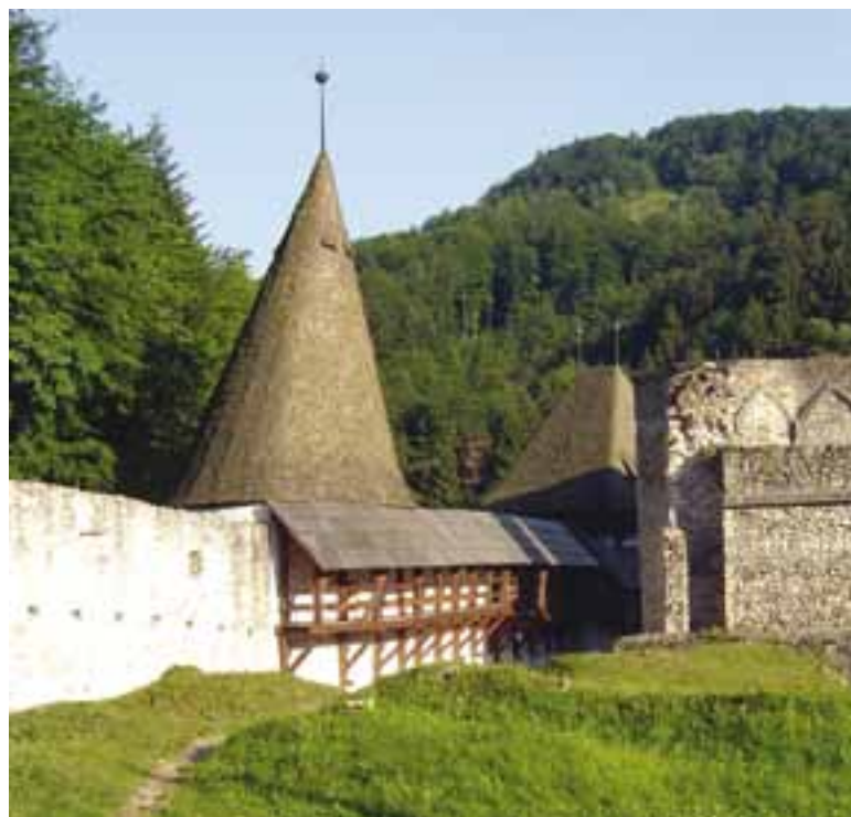
Poznosrednjeveško obzidje z obnovljenim lesenim obrambnim hodnikom v kompleksu kartuzije Žiče. Late medieval walls with renewed wooden defensive corridor in the complex of monastery Žiče.
